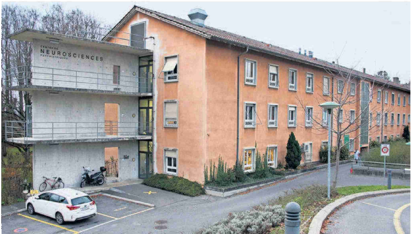
Le Centre de neurosciences psychiatriques est installé depuis quatorze ans dans une aile de l'Hôpital de Cery qui va être démolie.
